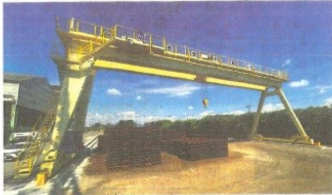
新設したクレーン
