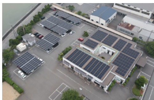
(姫路西工場 太陽光パネル設置の一部)
